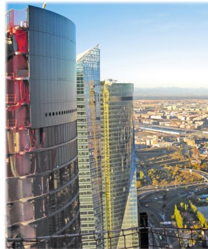
Diversos andamios en la construcción de la Torre Repsol. Madrid. España
