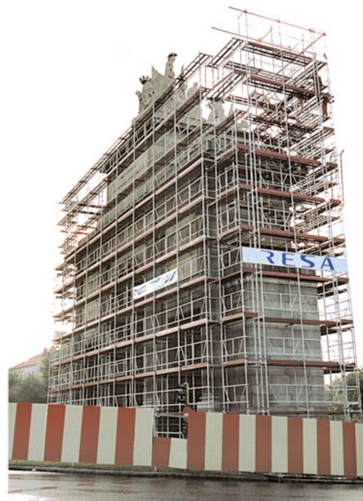
Andamio para rehabilitación integral de la Puerta de Toledo. Madrid
