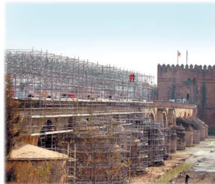
Andamio para rehabilitación del Puente Romano. Córdoba, España
