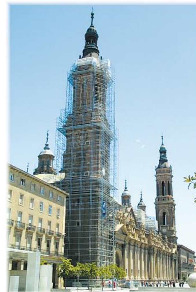
Andamio para rehabilitación de torre de la Basílica del Pilar. Zaragoza, España
