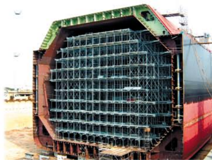
Andamio para construcción de buque gasero. Puerto Real. Cádiz, España
