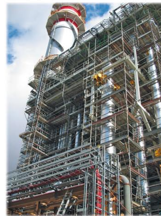
Escalera especial para acceso y construcción de LNG Adriatic. Algeiras
