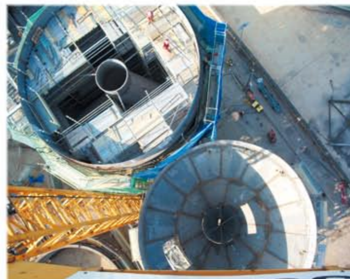
Montaje de andamio en absorbedores. Central Térmica Es Murterar. Alcudia
