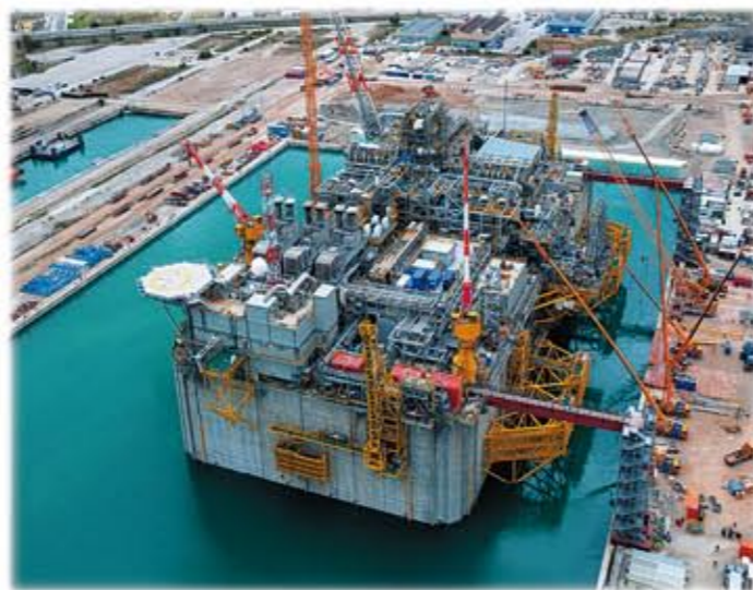
Andamios diversos para la construcción LNG "Adriatic". Algeiras. Cádiz
