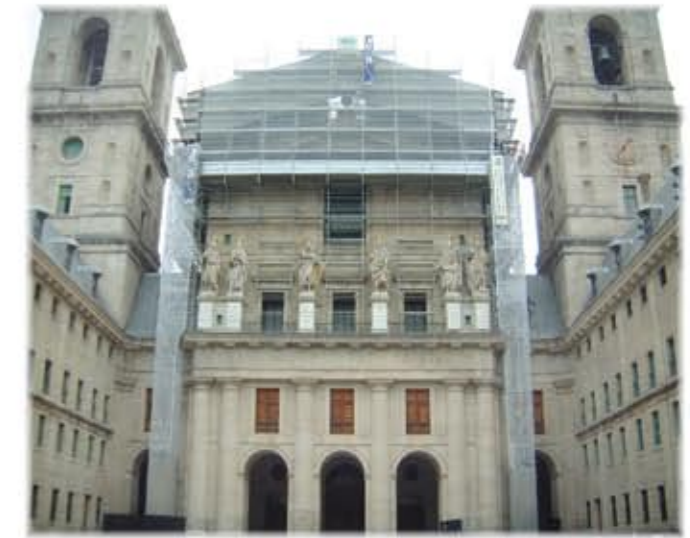
Andamio para rehabilitación del Monasterio del Escorial, Madrid
